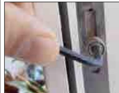
Откройте окно и осмотрите торец створки. Там должны быть торчащие круглые детали – они называются эксцентриками, или цапфами. На разной фурнитуре их вид немного различается: могут быть круглыми с гнездом для ключа по центру или без него либо овальными без каких-либо отверстий.
